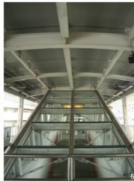
1.施設全景。2.外壁見上げ。3.ホーム。4.アプローチ。5.駅構内。
