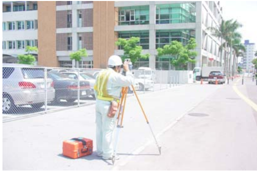
基準点測量状況
