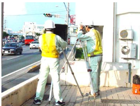
電子平板測量状況
