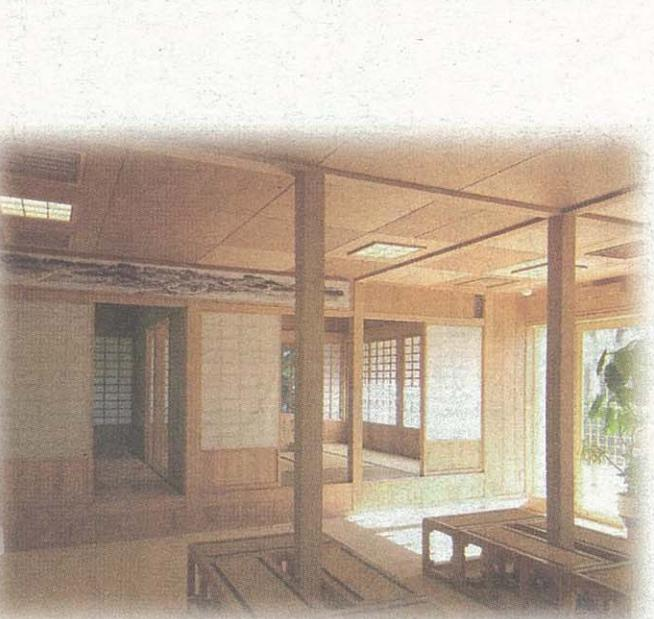
案内・休憩コーナーを設け、そこに読谷村や喜名区を紹介する写真や地図などのパネル、情報を発信する端末機を備えている。柱や梁などの主な部材は九州産のイヌマキを使い、継手・仕口も伝統的な工法を採用して沖縄の木造伝統技術の継承を図っている。
