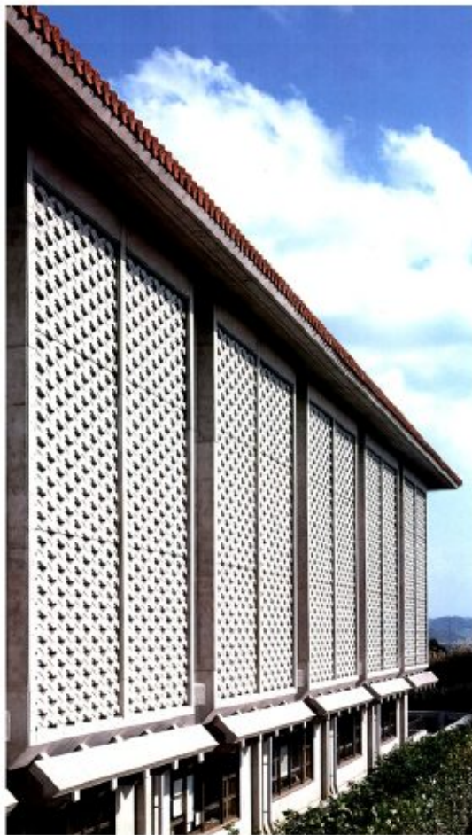
ベンチレーションの役割を持たせた プレキャストスクリーン
