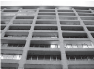
國場ビル 上：外観 中：犬走りに埋め込まれた玉石 下：雨端を模した庇フレーム
