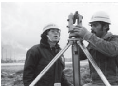
イランでの現場 上：杭打ちの様子 下：現場での福田俊次
