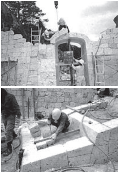
浦添ようどれの復元作業 上：ナーカ御門(石積み状況) 下：ナーカ御門(畳石設置) 出典：『史跡浦添城跡第1期(浦添ようどれ)整備事業報告書』(2007年)
